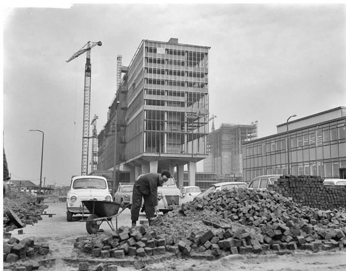
Technische Hogeschool Eindhoven in aanbouw 1962
